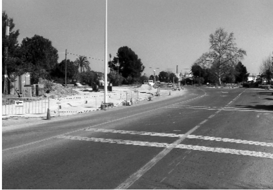
Les obres a la rotonda es troben en plena fase de realització
