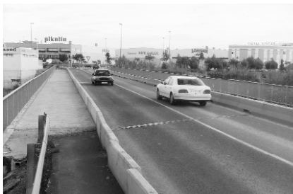
El pont entre les rotondes del Sol i l'Almàssera es troba en obres per dotar-lo d'un nou carril-bici (en els dos sentits)
