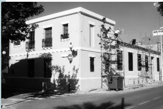
Casa de la Cultura en ple procés de rehabilitació de façana
