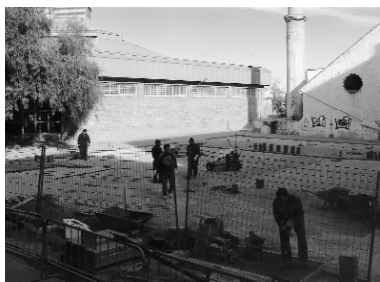
Les obres estan en marxa
