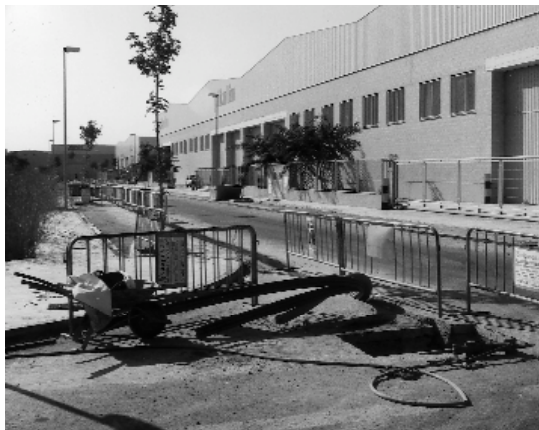
El procés d'instal·lació del cable ja està iniciat al polígon "Alqueria de Moret"
