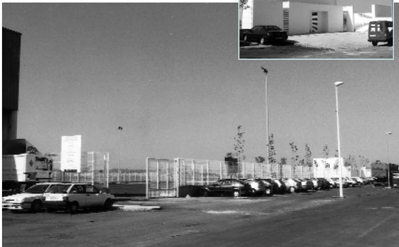
Aspecte exterior del nou aparcament de camions
