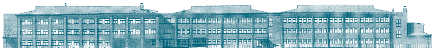
Façana nord de l'Institut una vegada reformat
