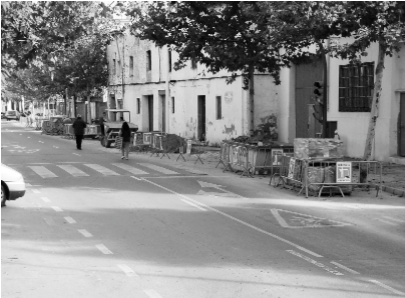
Vista de les obres de remodelació de les voreres del carrer València
