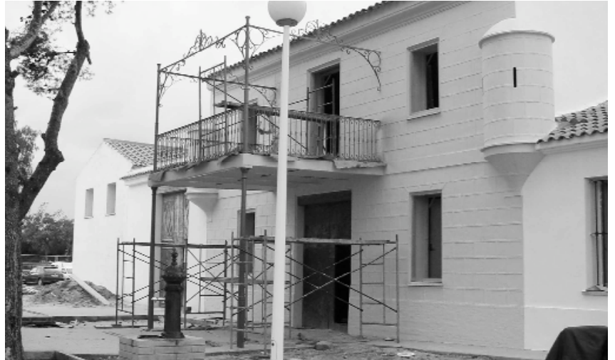
Façana de l'Alqueria de Moret en avançat estat de restauració
