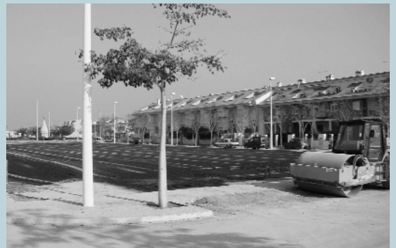
Ja s'ha asfaltat el solar destinat a la instal·lació dels barracons
