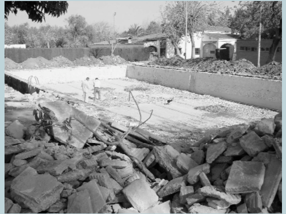
Aspecte de les obres
