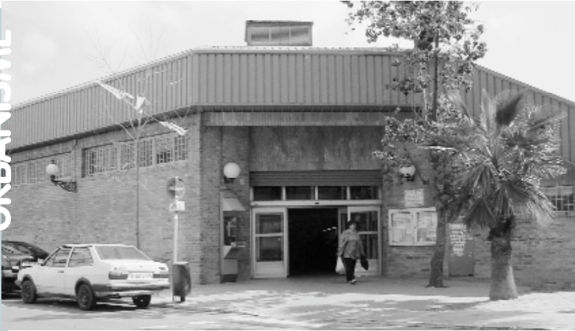
Façana del mercat municipal
