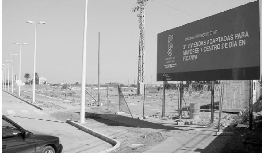
Las obras ya se han iniciado en este solar de la zona este de nuestro municipio
