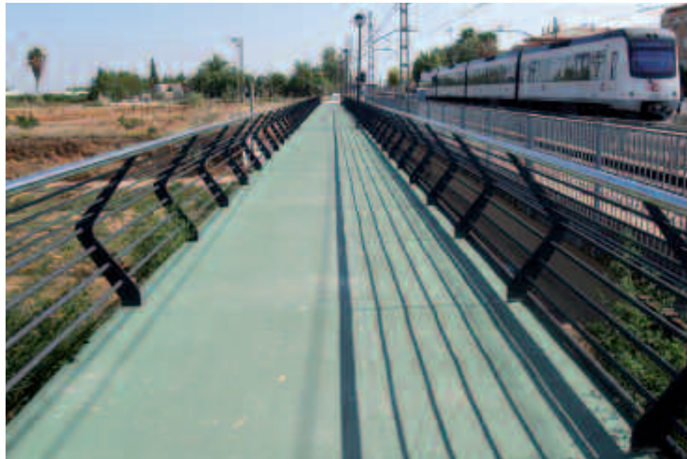
Passarel·la peatonal d'accés a l'estació de Metro de Paiporta
