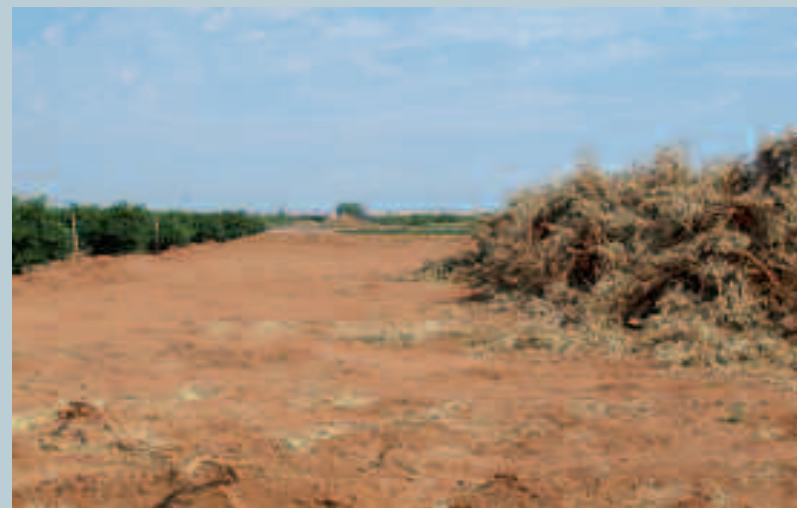
Obres de construcció de la Ronda Oest
