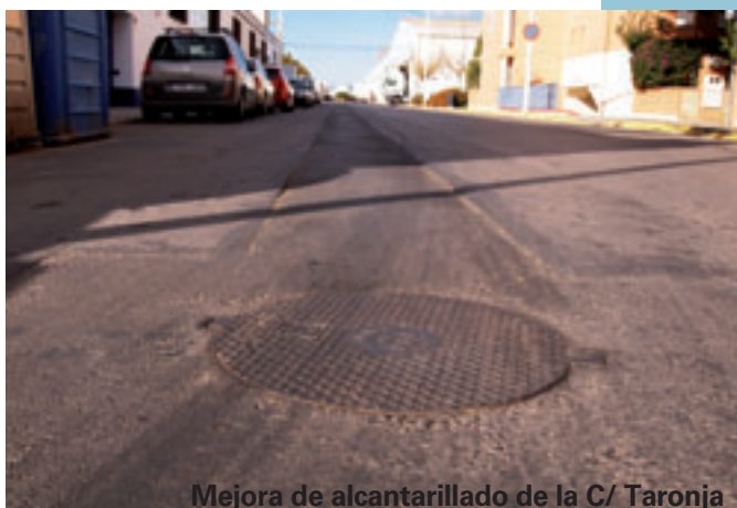
Mejora de alcantarillado de la C/ Taronja
