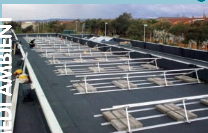
Instal·lació de plaques a la Piscina Coberta
