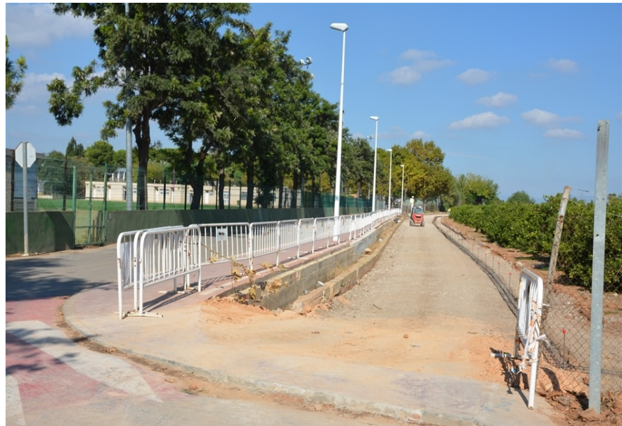
Fig. 7 Ampliación del camino de acceso al Polideportiv.
