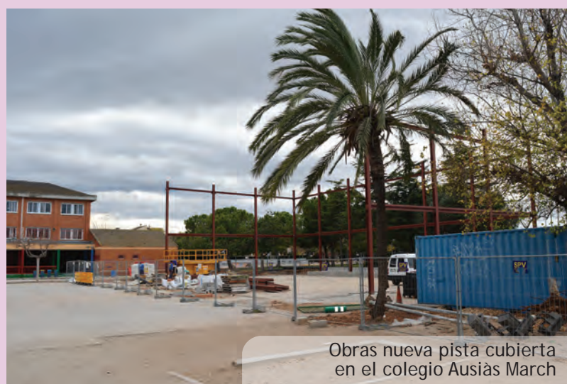
Continuación del trabajo de renovación de calles
